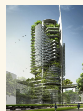
햐자와 양(T. R. Hamzah & Yeang, 말레이시아) 싱가포르 EDITT 타워(2010년 작) - 태양 전지, 자연 환기, 바이오 가스 발전 시설이 갖추어져 있으며 식재 공간이 건물 표면의 50%를 차지하고 있는 싱가포르의 26층 건물이다. 빗물과 중수도 용수를 재활용해서 건물 전체의 필요량 55%를 공급하며 오수는 비료나 바이오 가스 발전으로 처리된다.
