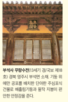
부석사 무량수전(13세기 경/국보 제18호) 광복 양주시 부석면 소재 기암 위에는 공로를 베풀어 단아한 주심포의 건물로 배흘림기둥과 팔각 지붕이 편안한 안정감을 준다.
