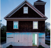
댄 플라빈 아트 인스티튜트 외관
