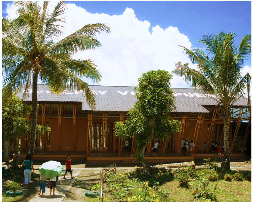
J사(말레이시아) 밀레니엄 대나무 학교 프로젝트 (대나무 건축, 필리핀/2010년 작) 필리핀의 환경을 고려하여 대나무를 주요 목재로 활용하여 채광과 통풍이 잘되고, 비용이 저렴할 뿐 아니라 A급 태풍에도 견딜 수 있는 안전한 학교이면서 긴급 피난처 역할을 담당하는 디자인이 이루어졌다.
