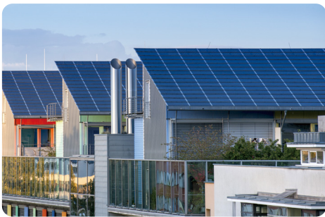
▲ 독일 프라이부르크의 태양광 설비를 이용한 주택
