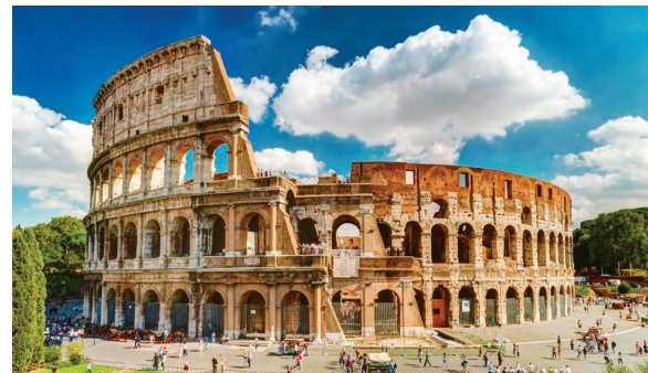
▲ 콜로세움(석재, 콘크리트/높이 48m, 지름 188m, 둘레 527m/80년 완공/로마) 세 개의 층 각각에 아치 80개를 배치하여 축조한 원형 경기장이다.
