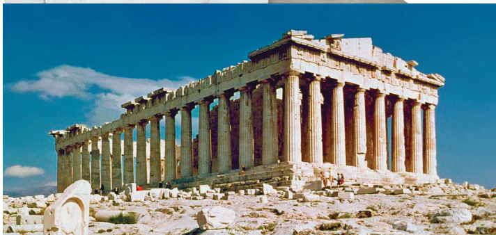
▲ 파르테논 신전(대리석/13.7×69.5×30.9m/기원전 447년 완공/그리스 아테네) 수직 기둥인 지주에 수평 돌보인 상인방을 올려 축조한 직육면체 형태의 신전이다.
