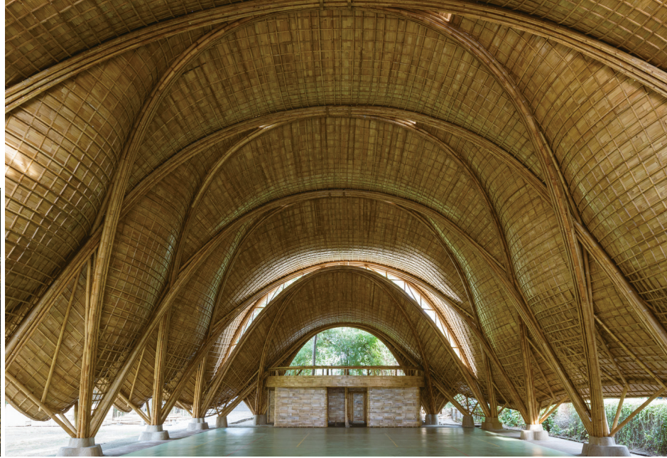
▲ IBUKU 스튜디오(인도네시아) 그린 스쿨의 아크(2021년) 지속가능발전전에 중점을 두고 친환경 소재인 대나무를 활용해 설계한 건축물이다. 비영리 사립 학교, 그린 스쿨 안에 세운 이 건축물은 체육관 겸 광장 역할을 한다.
